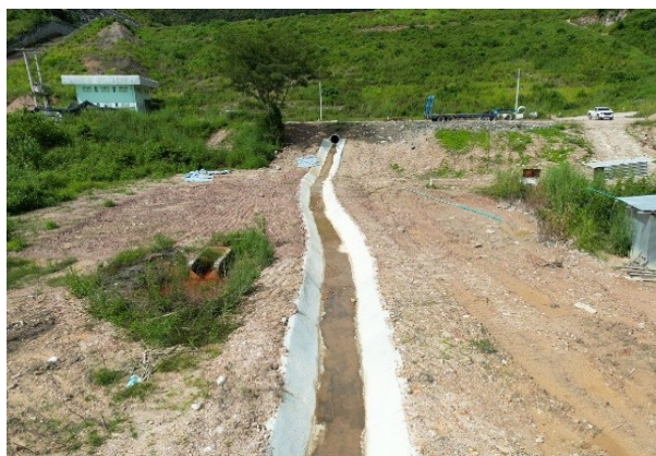
รูปที่ 1.6-6 ความก้าวหน้าการก่อสร้าง บริเวณ Stilling Basin ของอาคารระบายน้ำล้น (Spillways)
