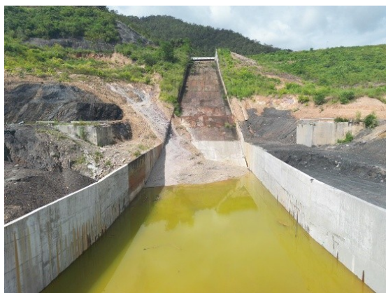
รูปที่ 1.6-6 ความก้าวหน้าการก่อสร้าง บริเวณ Stilling Basin ของอาคารระบายน้ำล้น (Spillways)
